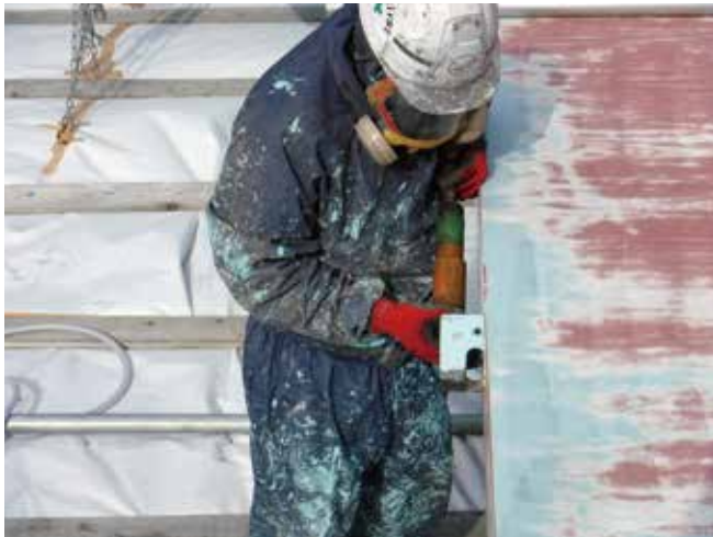
ケレン作業の様子
