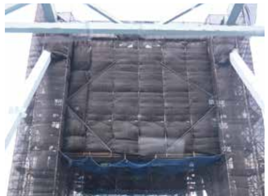
塗装補修の現場
