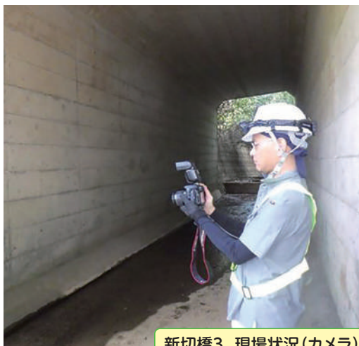
新切橋3 現場状況(カメラ)
