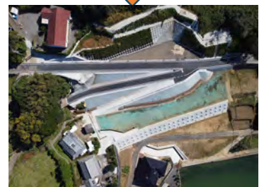
松浦市道浜ノ脇線他道路 (令和4年10月31日共用) (ドローン撮影：ウエノ・七洋工業JV様)
