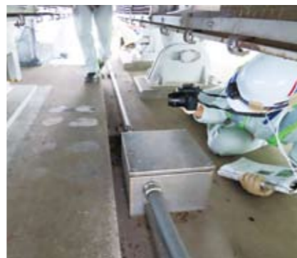
支承部点検状況(大島大橋)
