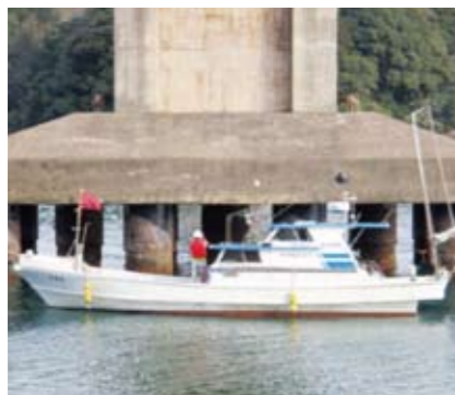
橋脚部点検状況(福島大橋)
