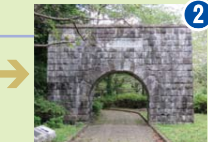
『石門』旧西山ダムの利水管を通していたトンネル部
