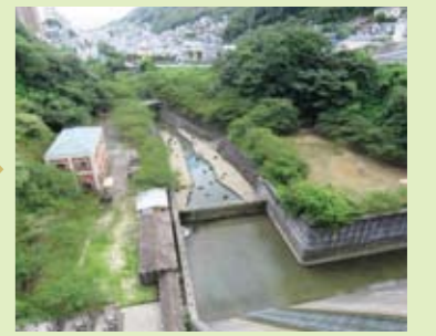
新西山ダムから下流を見下ろす
