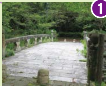
『高麗橋』もと、中島川上流部に架けられていた石橋アーチ橋
