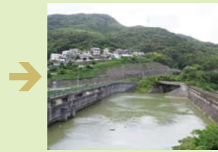
左新西山ダム 右旧西山ダム
