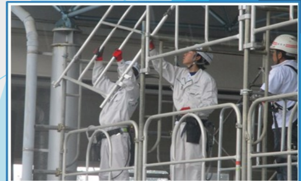
足場技能実習（令和5年度）
