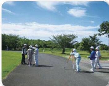
土木施工管理基礎研修
