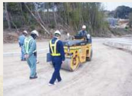
プルーフローリング試験(路床工)
