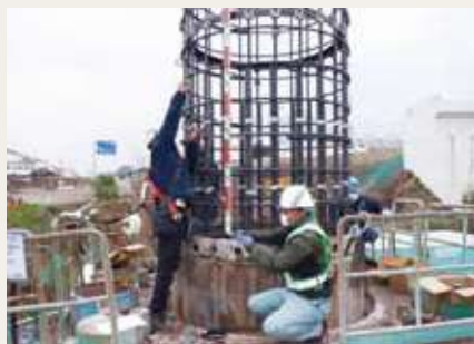
籠筋建込状況・ラップ長確認 (場所打ち杭工)
