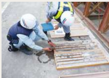
場所打ち杭支持層確認 (調査ボーリングコア確認)
