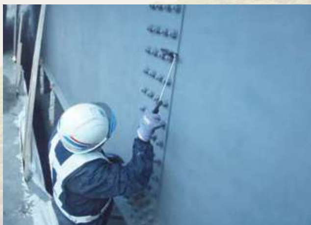
旧塗膜剥離後の1種ケレン状況確認
