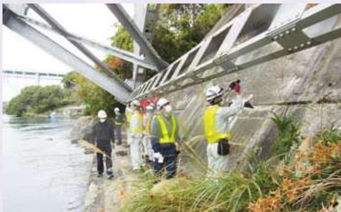
センター職員による橋梁点検立会
