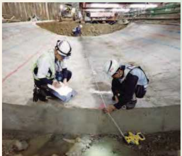
インバート出来形検測状況
